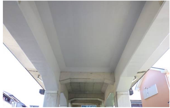
高架橋表面保護工施工
