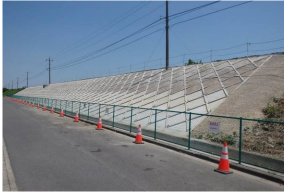
盛土のり面改良
