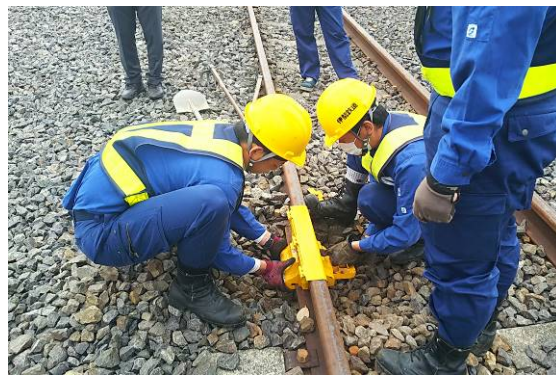
レール応急処置器取扱訓練
