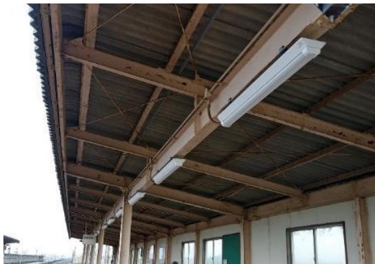
ホーム照明等更新
