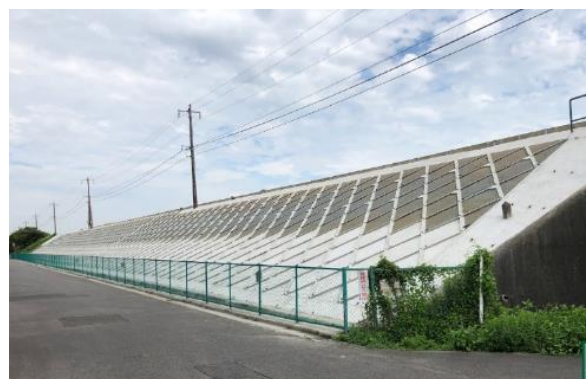
盛土のり面改良
