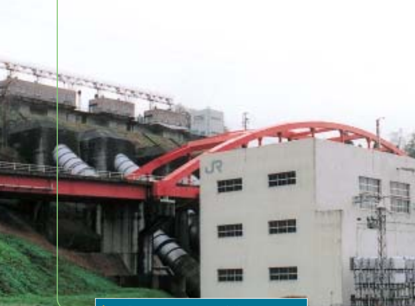
▶ 信濃川発電所。発電能力は合計で44.9万kW
