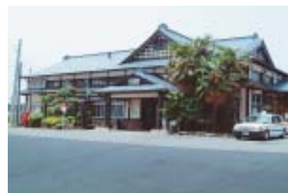
霊山神社を模した木造武家造で、2002年の国土交通省「東北の駅百選」にも選ばれた東北本線伊達駅。駅舎内にコミュニティスペース「駅なかプラザ」を併設
