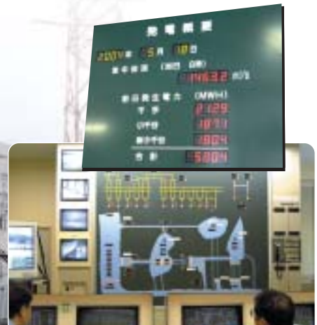
▶ 水力発電所の全ての機器を制御する総合制御所。降水データなどの情報に基づき発電量の予測も行う
