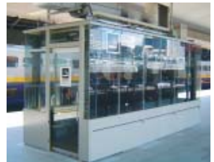
分煙化をさらに進めるため、完全に個室として排煙設備を備えた喫煙所を一部新幹線駅ホームに設置しました
