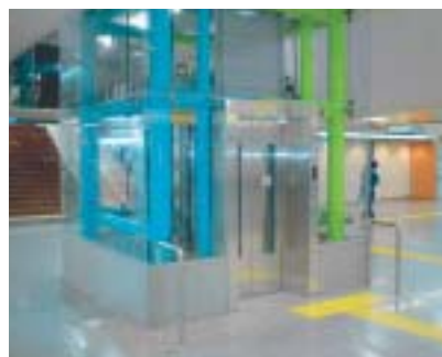
バリアフリー対応のためエレベーターの整備を順次進めています
