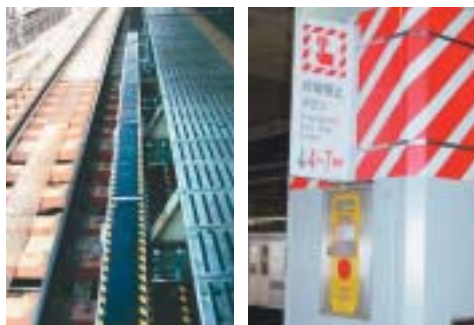
駅のホームでは、転落検知マット(左)や緊急停止スイッチ(右)のほか、さまざまな安全対策を講じています
