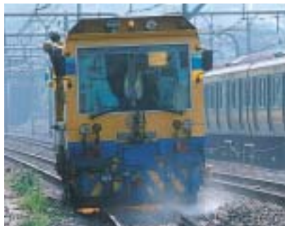
中央・総武線飯田橋～市川間でレールの削正作業を行う車両
