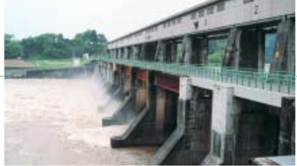
▶ 発電に必要な水を取水する宮中取水ダム
