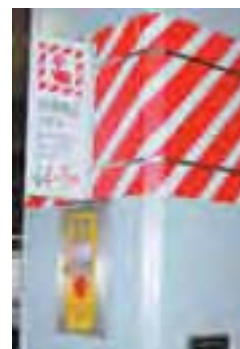
ホーム柱に設置してある「非常停止ボタン」を扱うことにより、運転士に危険を知らせます
