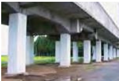
新幹線高架橋柱耐震補強を当初の計画よりも前倒して実施しています
