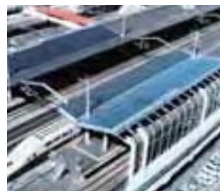
高崎駅の新幹線ホームの屋根に設置された太陽光パネル
