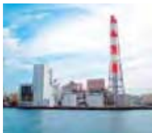
川崎火力発電所3号発電機において、燃料を灯油から天然ガスへの転換作業を2006年6月に完了
