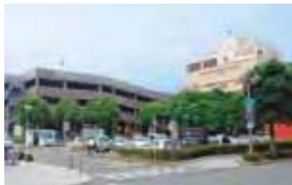
甲府ステーションビル(株)の駅ビル駐車場を使用した、甲府駅の「パーク&ライド」
