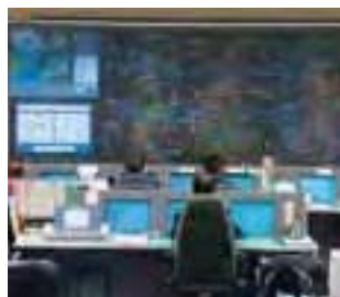
リアルタイムに電力供給量を監視・制御する給電指令
