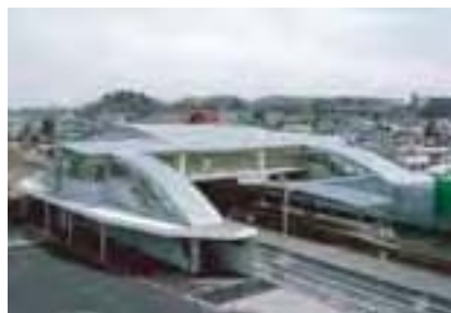
曲面天井や多くのガラス面を使用して開放感を持たせた、八高線箱根ヶ崎駅
