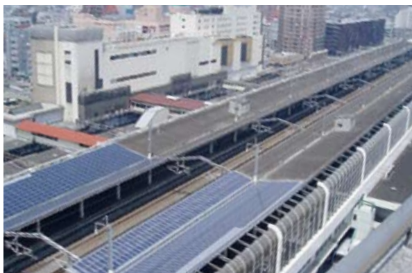
高崎駅のホーム屋根に設置された太陽光発電パネル
