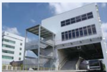
Smart Station 実験棟
