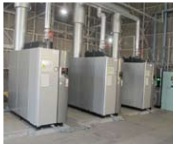
貫流ボイラの燃料変更によるCO 2 削減
