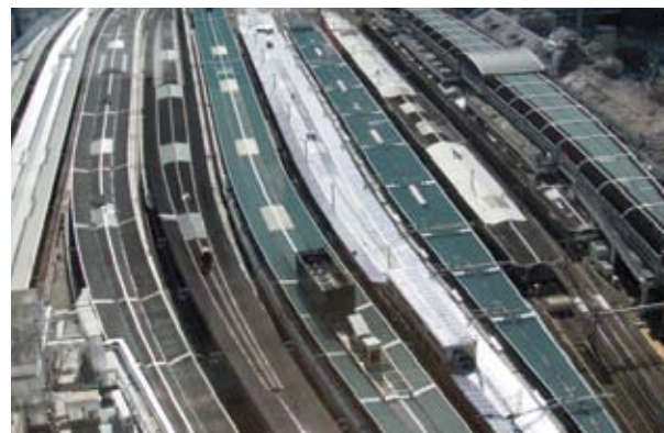
東京駅の東海道線ホーム(9・10番線)に設置された太陽光発電パネル
