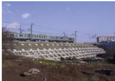
コンクリート製の格子枠工
