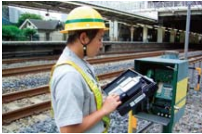
「保守作業用ハンディ端末」による線路閉鎖手続
