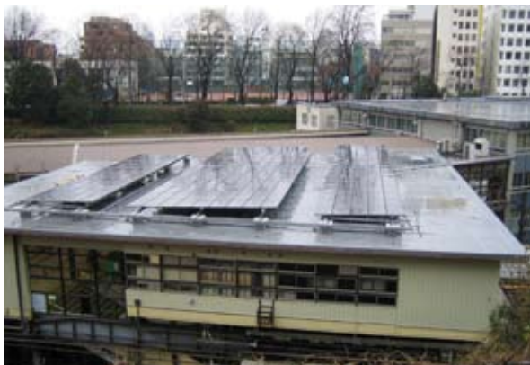
四ツ谷駅の赤坂口本屋に設置された太陽光発電パネル
