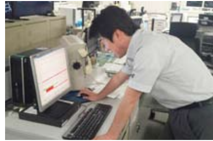
指令室の保守作業確認端末
