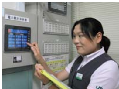
社員の取り組みを支援する「電力量計測装置」
