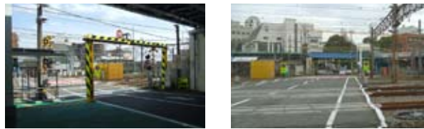
廃止となった東海道線総持寺踏切
