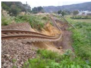
盛土の損傷例及び補強イメージ
