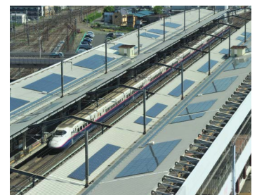
福島駅に設置された太陽光発電設備
