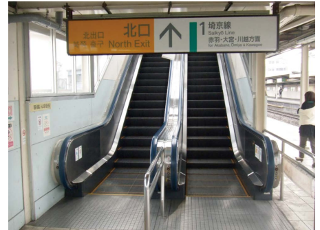
埼京線十条駅上りホーム
