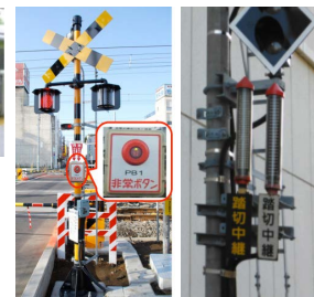
(非常ボタン) (特殊信号発光機) 踏切支障報知装置
