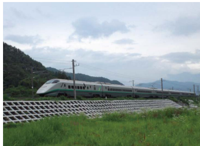
盛土のり面工 (吹付砕工)
