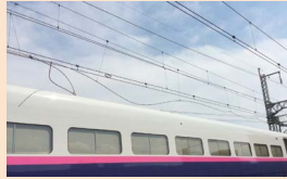
2015年4月29日 東北新幹線郡山駅構内での架線 切断による輸送障害
