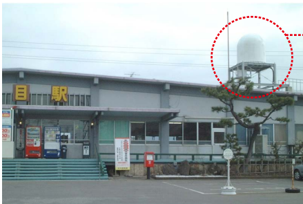
羽越本線余目駅屋上に設置されたドップラーレーダー
