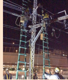
2015年8月4日 根岸線横浜～桜木町間での 架線切断による輸送障害
