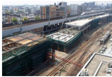
信越本線新潟駅付近高架化
