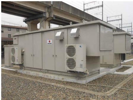
久喜変電所電力貯蔵装置
