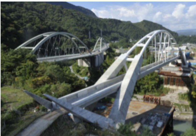
吾妻線 第三吾妻川橋りょう
