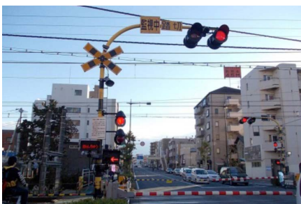
警報機を道路の上方に設置。
