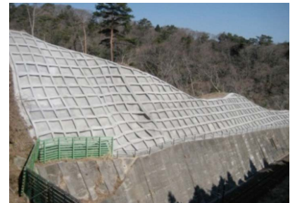
自然斜面防護工 (吹付砕工)
