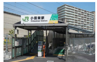
南武線小田栄駅
