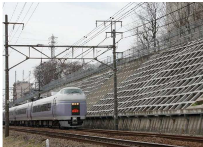
切取りの面工 (吹付砕工)
