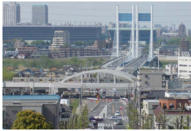
南武線稲城長沼駅付近高架化
