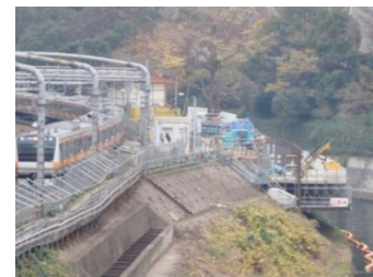
大規模地震対策(盛土の耐震補強)
