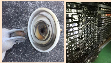
2016年3月15日 高崎線籠原駅構内電気設備故障に伴う輸送障害
