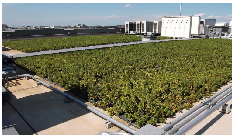
千葉支社ビルの屋上緑化
