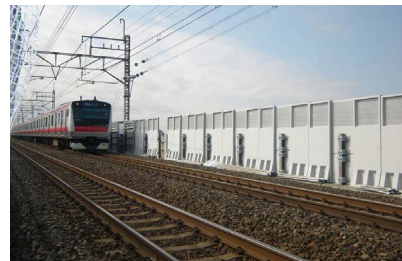
京葉線 潮見～新木場間
