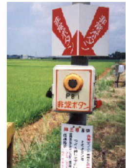
踏切支障報知装置
