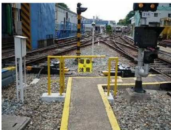
車庫構内 線路横断通路安全柵
