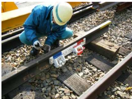
土木課 レール応急処置器取扱訓練
