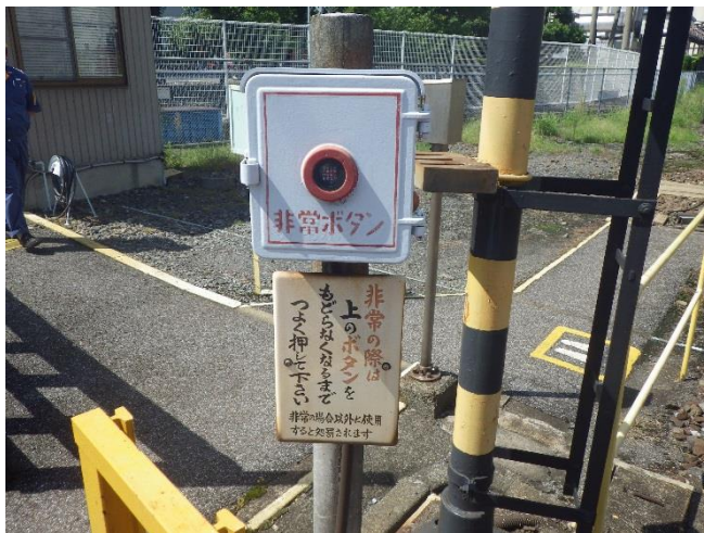
押ボタン式踏切支障報知装置
