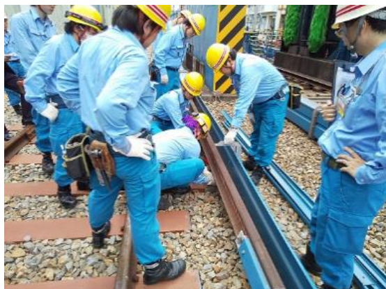
サードレール復旧訓練
