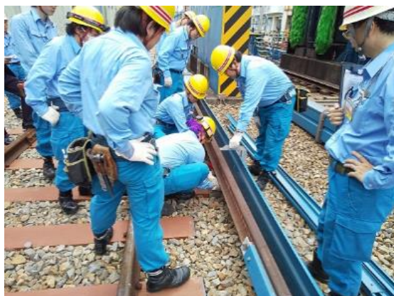
サードレール復旧訓練
