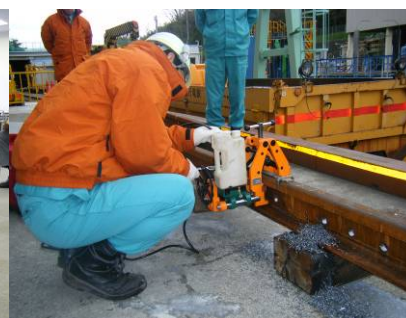
レール折損応急処置訓練
