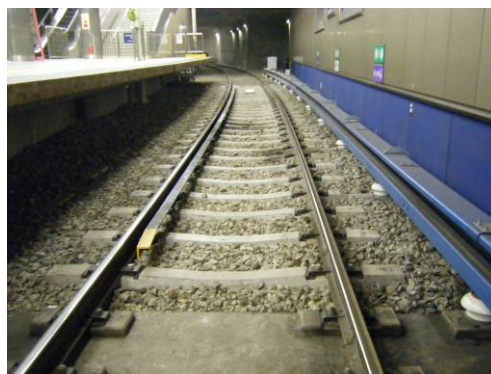
千里中央駅北端部木まくらぎ更換後全景
