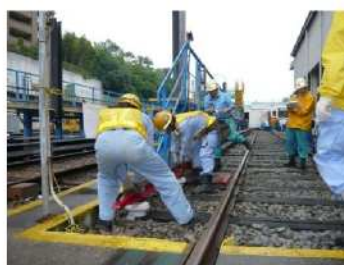
サードレールエンドアプローチ取付
