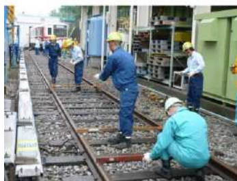
軌道変位整備
