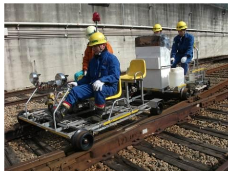
レール探傷検査風景
