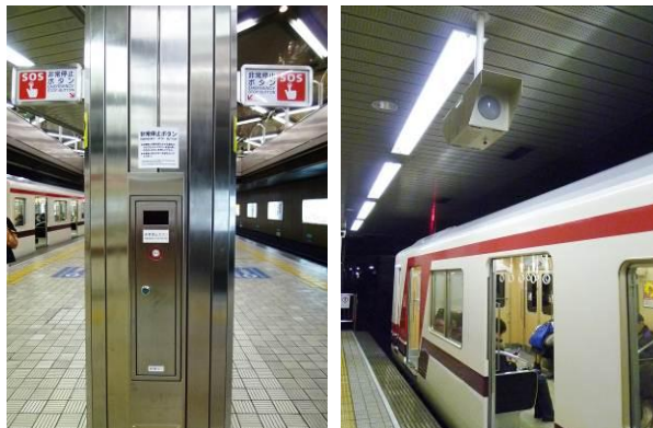
(非常停止ボタン)
