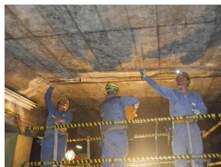
鉄道構造物全般検査風景
