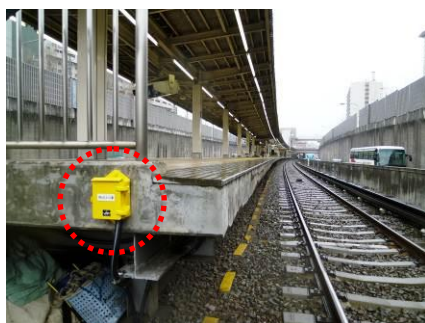
列車接近警告灯 点灯スイッチ
