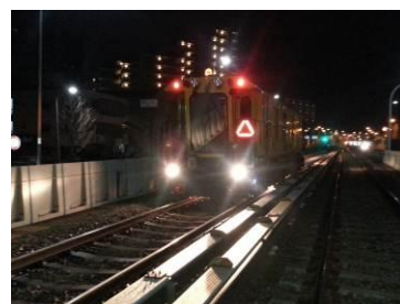
レール削正施工風景
