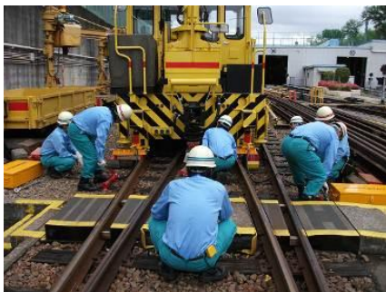
軌道モーターカー脱線復旧訓練
