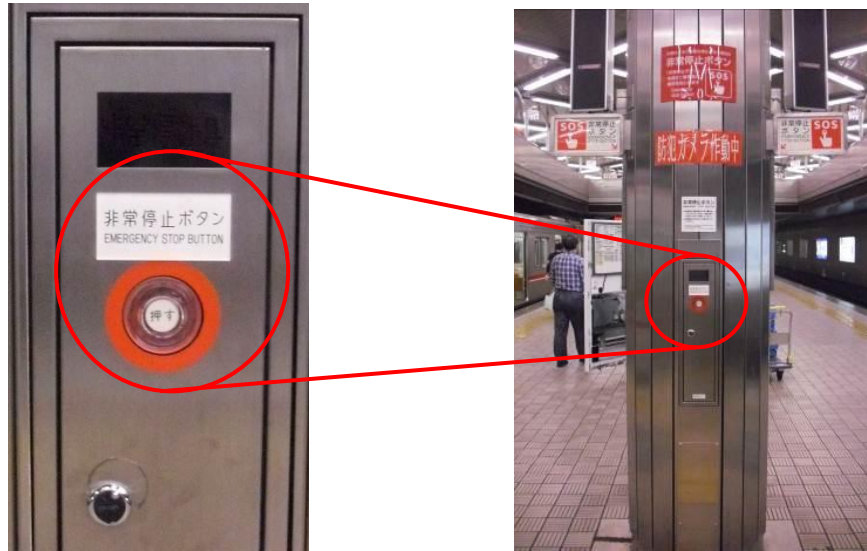
非常停止ボタン
