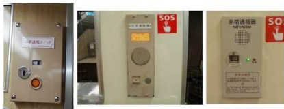
車内非常通報装置(車内側の操作器)
