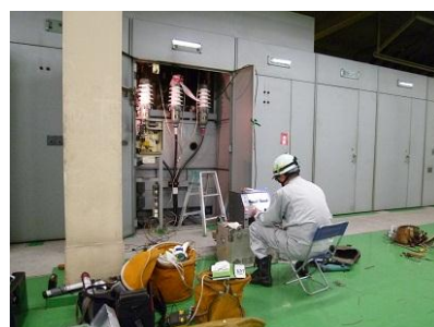
劣化診断風景
