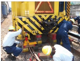
軌道モーターカー脱線復旧訓練
