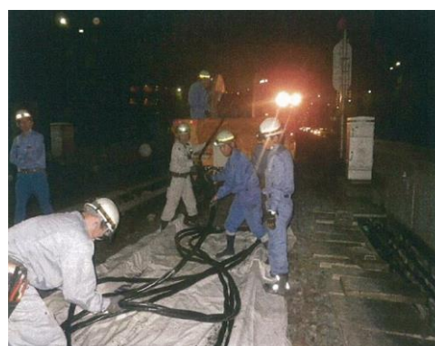
高圧ケーブル取替工事風景
