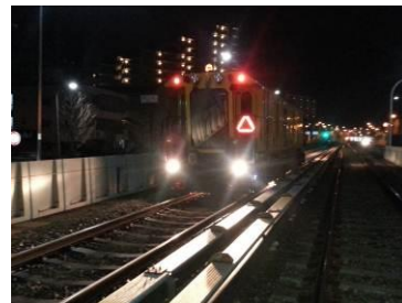
レール削正施工風景
