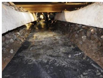
剥落防止工事施工後
