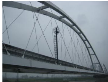
淀川橋梁風速計
