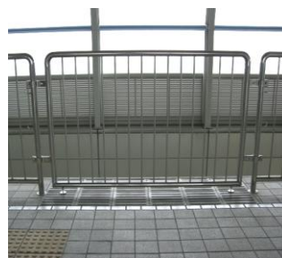
固定柵による転落防止
