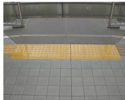
ホーム縁端警告ブロック
