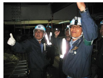
駅舎桁落橋防止装置設置工事
