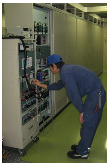
信号保安設備点検
