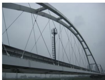
淀川橋梁風速計
