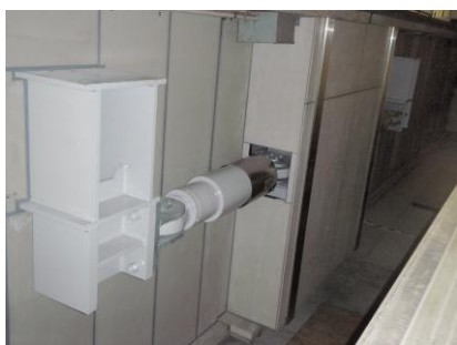
駅舎耐震補強工事・・・支柱とホーム桁をダンパーで連結し、駅舎の耐震を図る。
