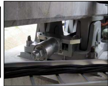
PC軌道桁落橋防止工事・・・PC軌道桁の支承（根もと）を連結し落橋を防止する。
