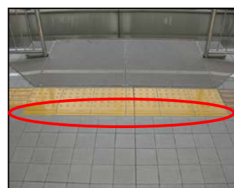
ホーム縁端警告ブロック
