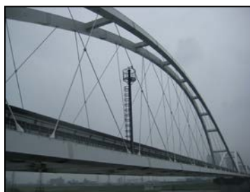
淀川橋梁風速計
