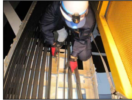
配電ケーブル点検
