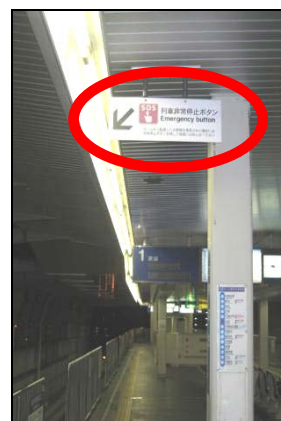
設置箇所案内看板
