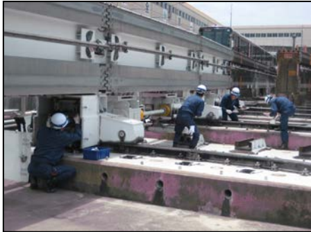
分岐器点検 (鉄道のポイントに相当)
