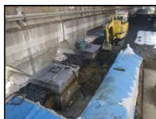
車両基地の留置線の耐震対策・・・軌道軸直角方向のズレ止めブロックを設置
