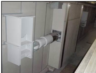
駅舎桁落橋防止・・・駅舎の躯体 (支柱とホーム桁) を制震ダンパー (振動吸収装置) で連結して耐震性の向上を図る
