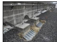
車両基地の留置線の耐震対策・・・軌道軸直角方向のズレ止めブロックを設置
