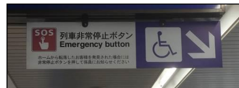
設置箇所案内看板
