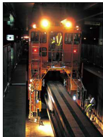
保守車両による点検
