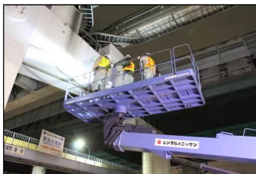
高所作業車による点検訓練
