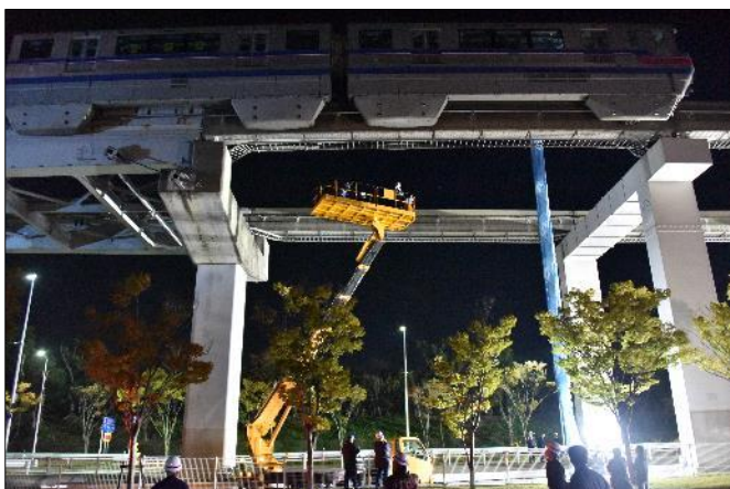
高所作業車での点検訓練
