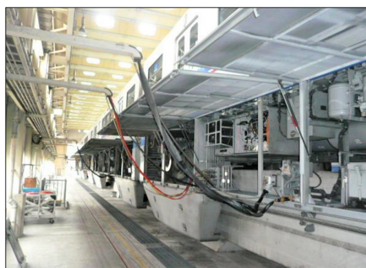
(検査の様子④) 総合検査
