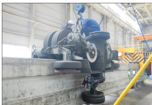
(検査の様子②) 台車吊り上げ
