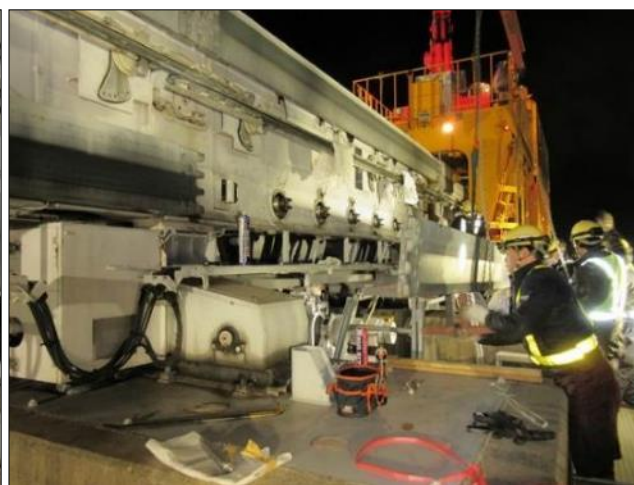
分岐器点検の様子2
