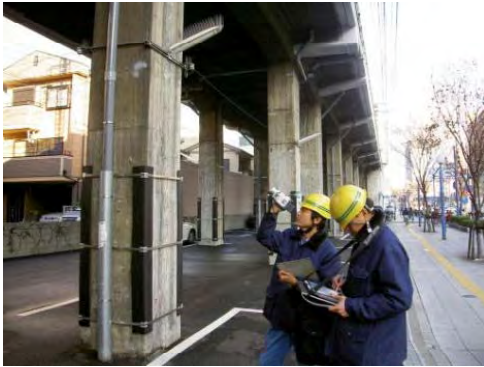
【高架下からの目視検査】
