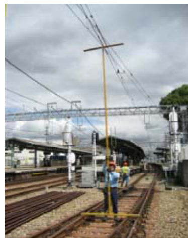
【交差装置点検】
