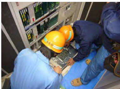
【信号設備障害復旧訓練】
