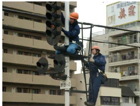
【信号機の定期検査】
