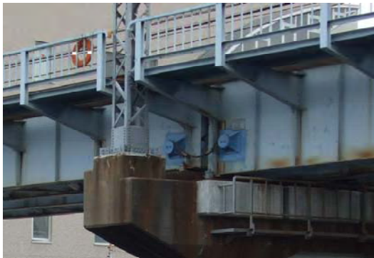
【桁連結及び桁受け部拡幅工法】
