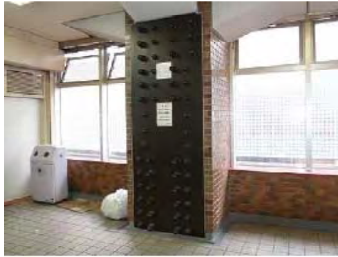
【一面せん断補強工法】
