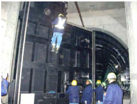
【トンネル内水防門扉開閉訓練】
