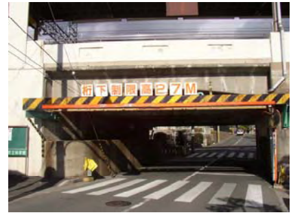
【橋桁防護工(桁)】
