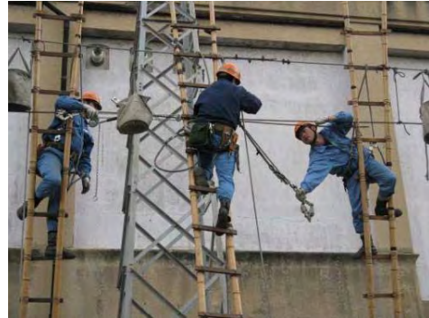
【電車線断線復旧訓練】
