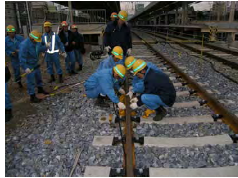
【レール折損事故応急復旧訓練】
