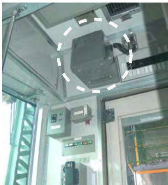
【運転状況記録装置】
