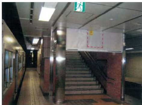
【防火防煙シャッター】
