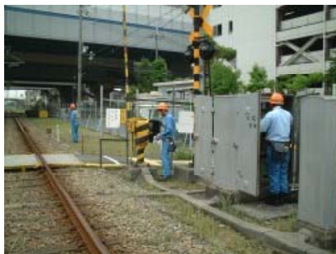
【踏切保安装置の定期検査】
