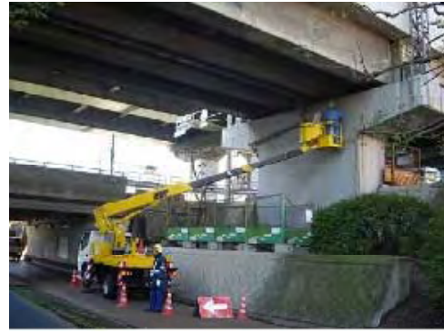
【近傍での詳細目視検査】
