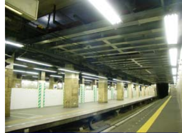
【コンコース中床版設置状況】
