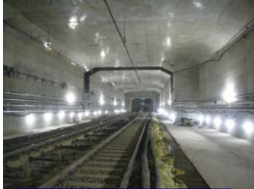
【新設構造物構築状況】
