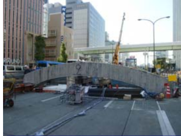
【既設構造物撤去状況】
