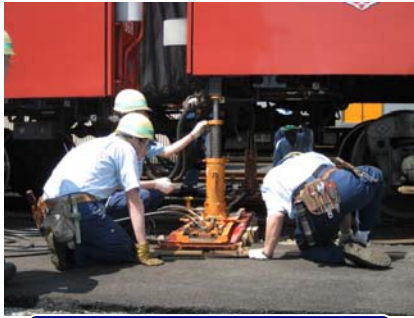
【脱線復旧訓練】
