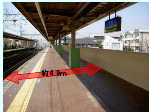
【プラットホーム拡幅後】
