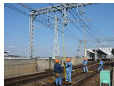
【交差装置点検】
