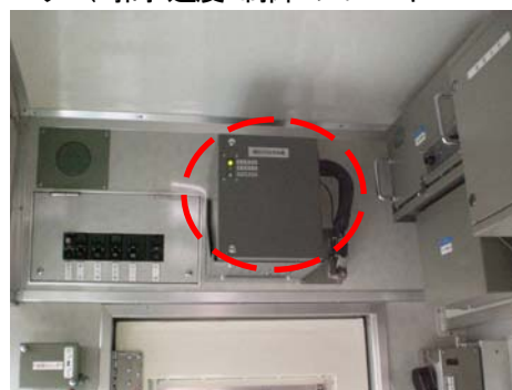
【運転状況記録装置】
