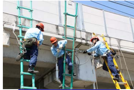
【電車線断線復旧訓練】
