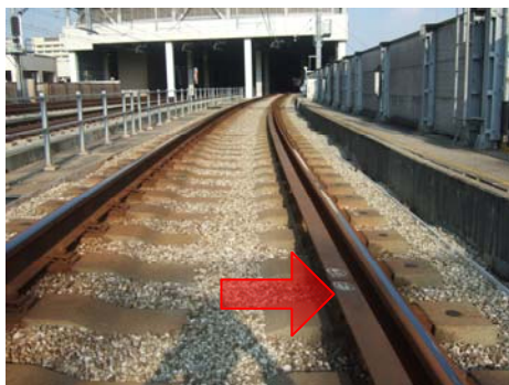
【脱線防止ガード 設置現場】
