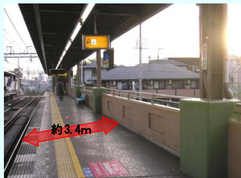
【プラットホーム拡幅前】
