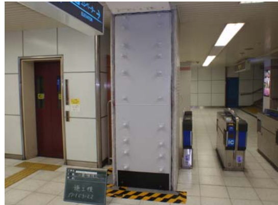
【一面せん断補強工法】
