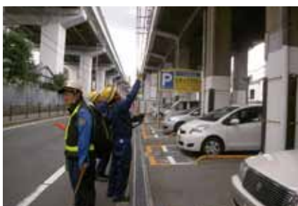
橋梁下面からの目視検査
