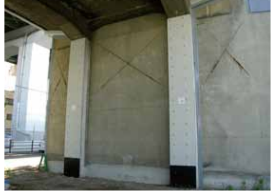
一面せん断補強工法
