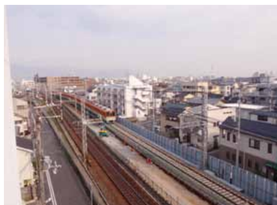
仮線工事現場(西宮市内)
