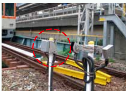
破線内がIDアンテナ
