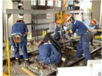
信号設備障害復旧訓練
