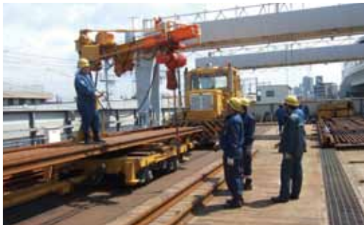
レール運搬台車取扱い講習
