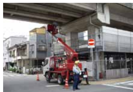
近傍での詳細目視検査
