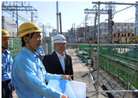
鳴尾連立工事視察（社長）
