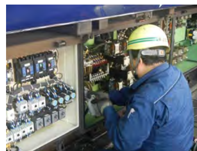
状態・機能検査（月検査）
