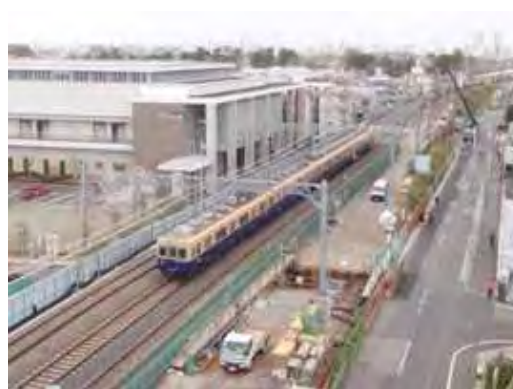
高架橋工事現場（西宮市内）
