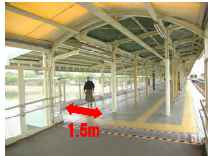
武庫川駅上りホーム
