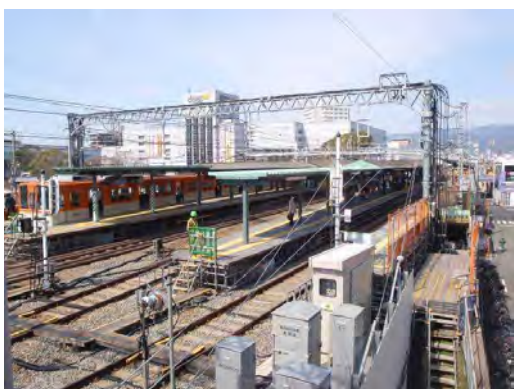
甲子園駅東方 仮ホーム化
