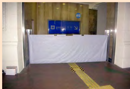
シート式水防施設 左：平常時 右：設置時
