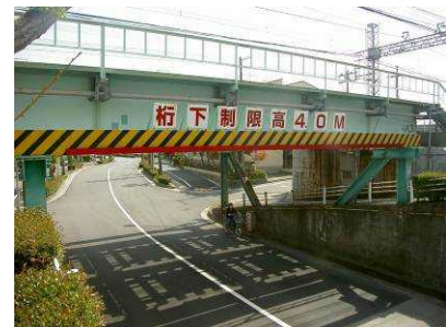
橋桁防護工(桁)
