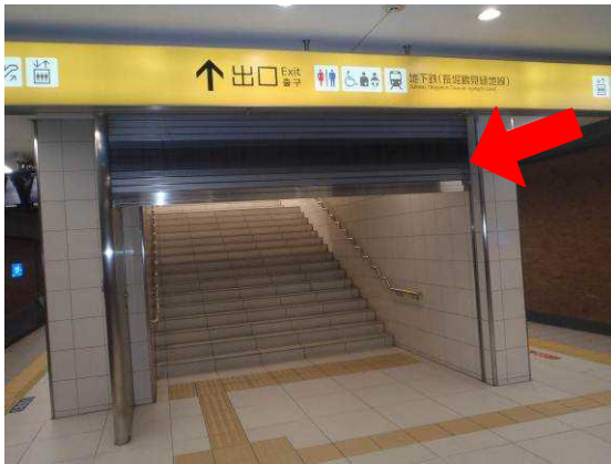
防火防煙シャッター
