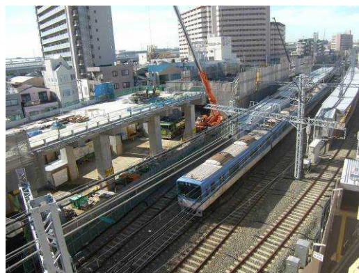
高架橋工事現場（青木駅部）
