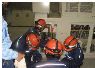
変電設備障害復旧訓練
