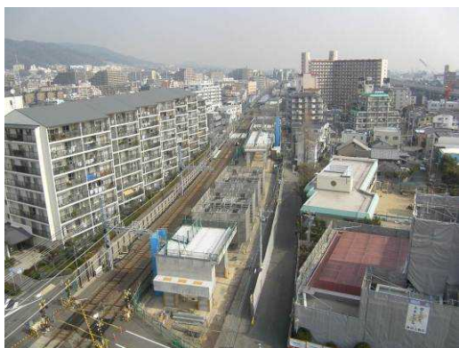
高架橋工事現場（魚崎駅・青木駅間）
