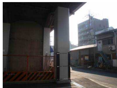
鋼板巻き立て補強工法
