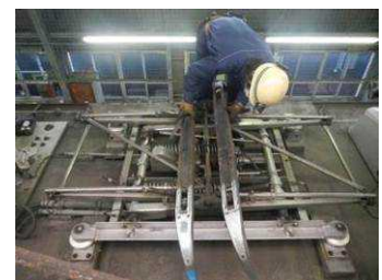
状態・機能検査(月検査)
