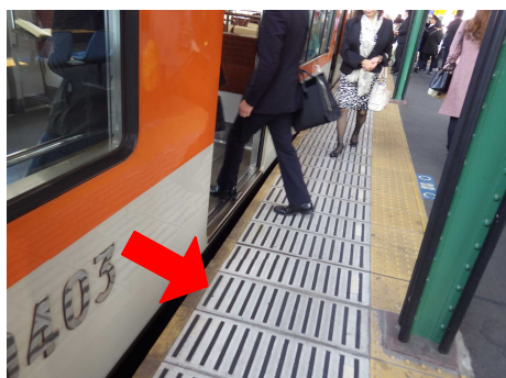
楡状ゴム 設置状況
