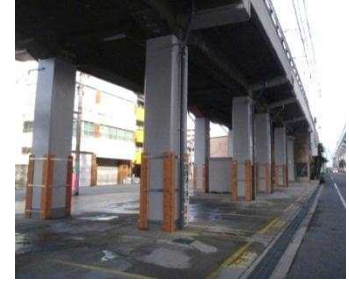
鋼板巻き立て補強工法
