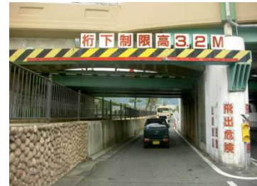
陸橋防護工(桁)
