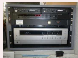
緊急地震速報放送装置
