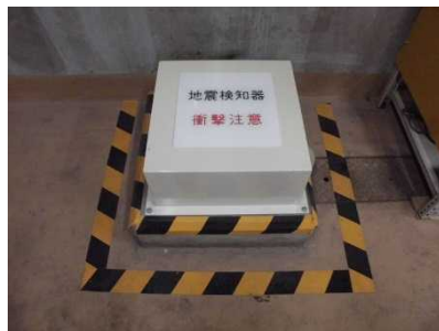
地震検知センサー
