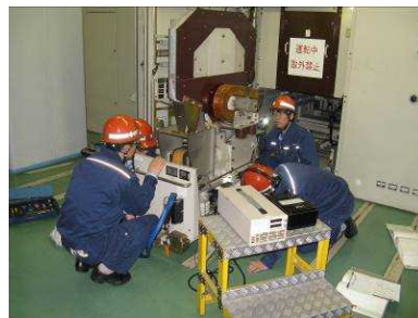
変電設備障害復旧訓練
