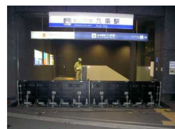
地下駅水防訓練
