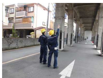
橋梁下面からの目視検査
