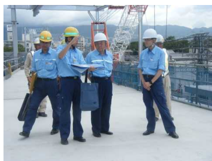
鳴尾連立工事視察 (社長)
