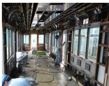
リニューアル工事の状況
