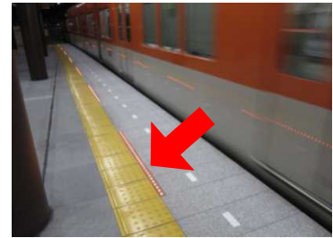
ホーム床面発光式列車接近表示器
