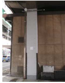
一面せん断補強工法
