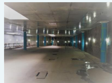
躯体構築状況
