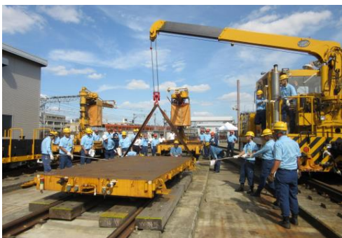
作業用トロッコ脱線復旧訓練
