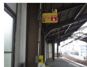
非常通報ボタン
