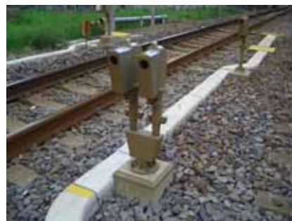
踏切障害物検知装置
