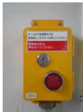
非常通報ボタン
