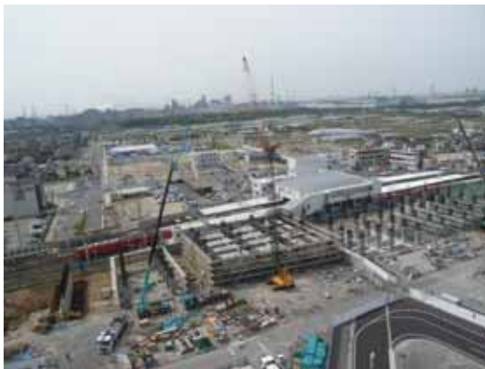
太田川駅付近高架化工事
