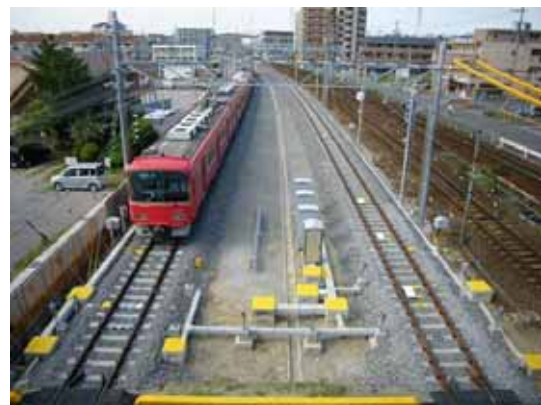
青山駅付近高架化工事
