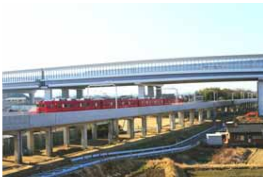
三河線・三河八橋駅～若林駅間
