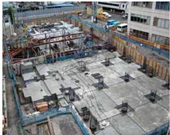
建設中 鉄道業務棟
