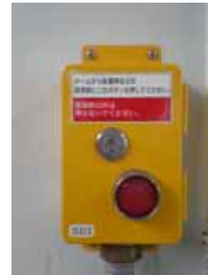
非常通報ボタン
