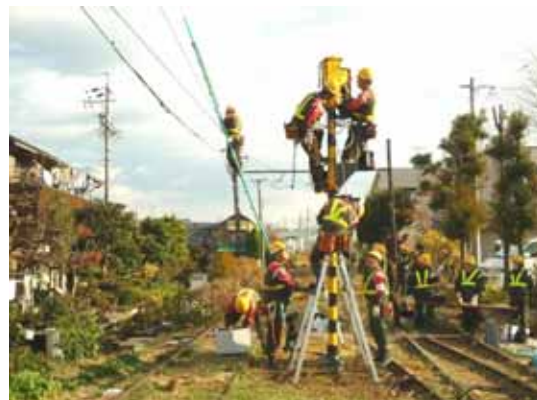
電気事故復旧訓練
