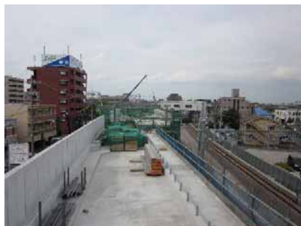
青山駅付近高架化工事
