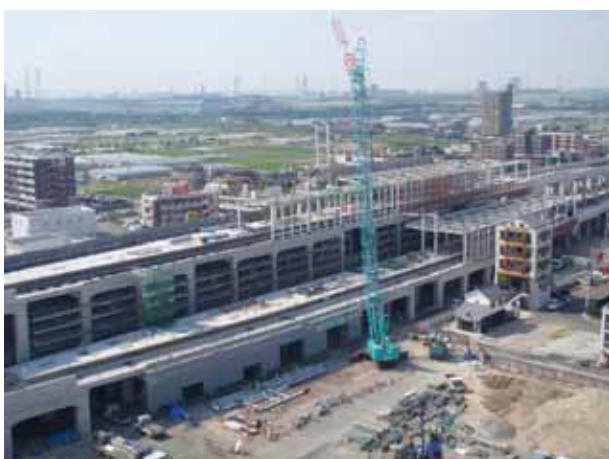
太田川駅付近高架化工事
