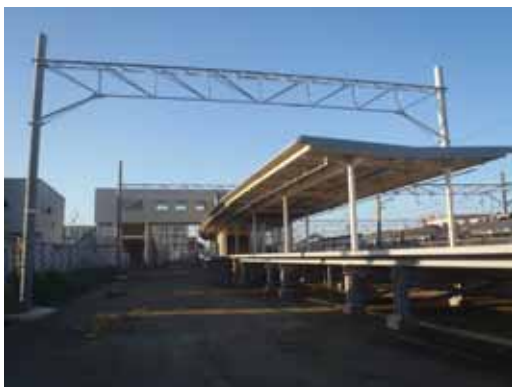
布袋駅付近高架化工事
