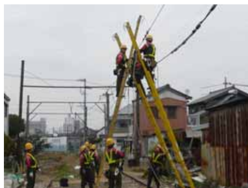
電気事故復旧訓練
