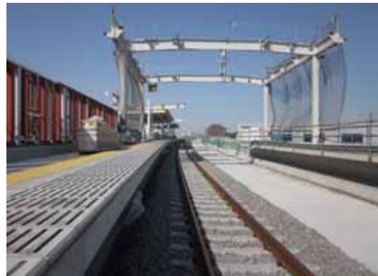
青山駅付近高架化工事
