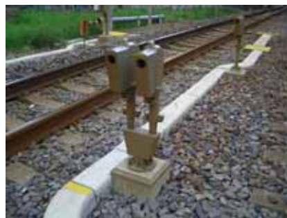
踏切障害物検知装置
