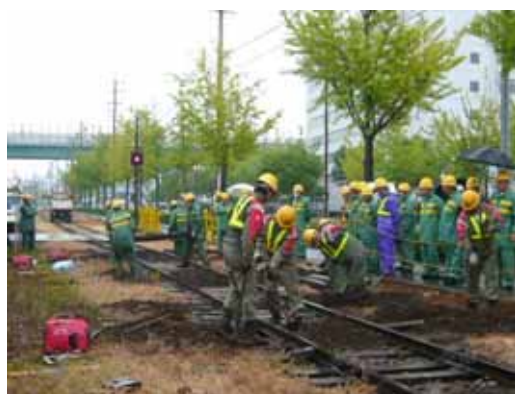
土木部脱線復旧訓練
