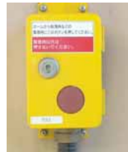
非常通報ボタン
