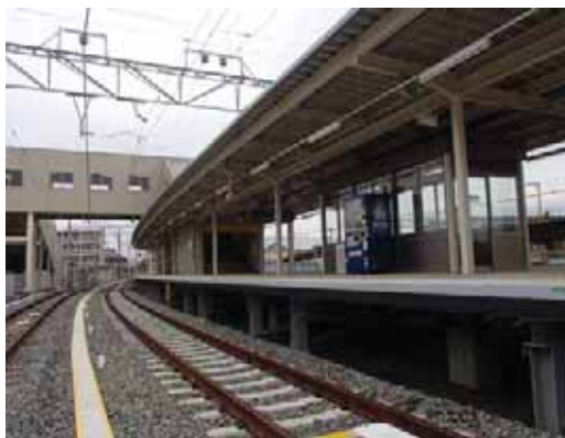
布袋駅付近高架化工事
