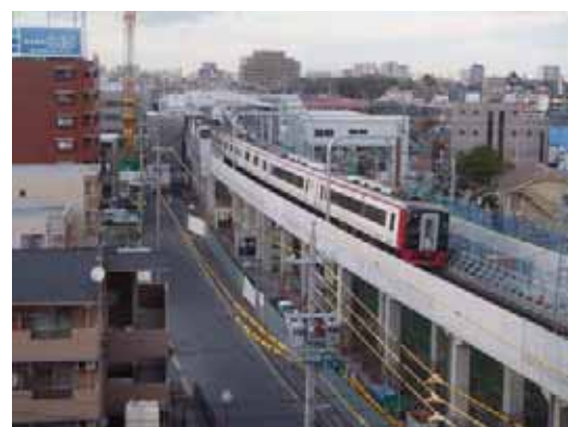
青山駅付近高架化工事
