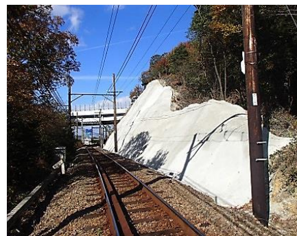
大村-樫山駅間 法面補強
