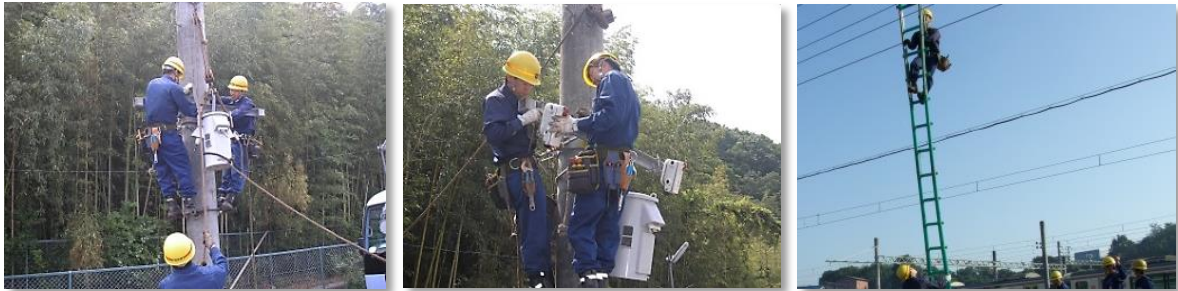
電路班 柱上変圧器吊替・架線の吊替の習熟教育
