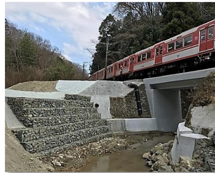
藍那-木津駅間 藍那第2橋梁護岸補強
