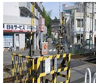
踏切非常通報押ボタン
