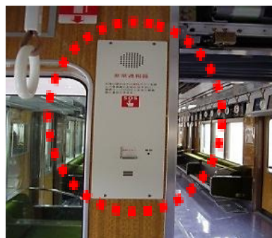
車両の非常通報装置
