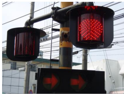
全方位式踏切閃光灯
