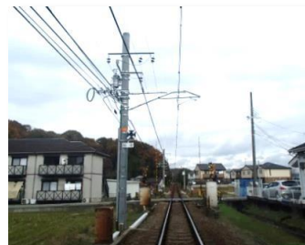
道場南口-神鉄道場駅間 支持物建替
