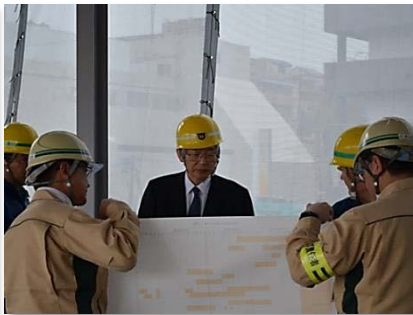
鈴蘭台駅前再開発工事現場
