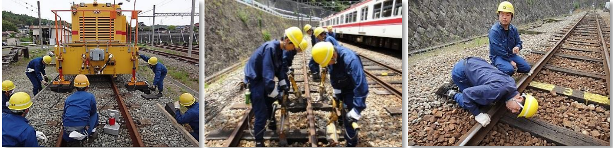
経験浅薄者のためのモーターカー脱線復旧および軌道付き固め教育
