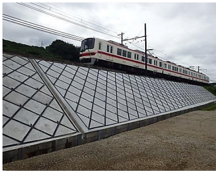
神鉄道場-横山駅間 法面補強
