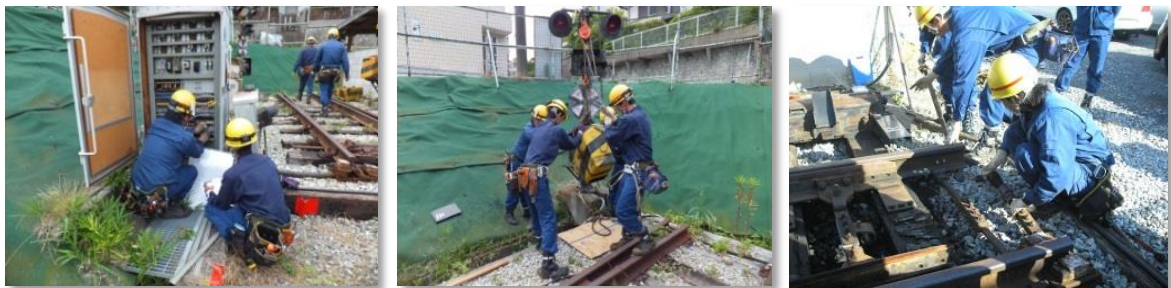
通信・信号班 踏切リレーボックス内の配線・転てつ器の習熟教育
