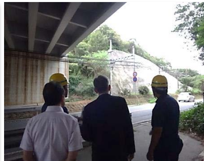
大村—樺山駅間法面
