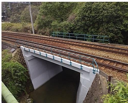
唐櫃台-有馬口駅間 第2下川橋梁補強
