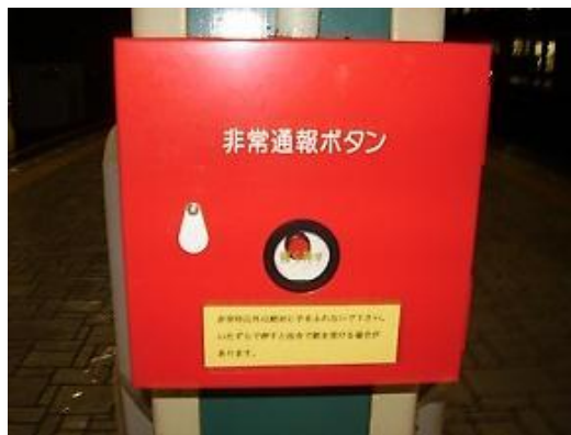
ホーム非常通報ボタン
