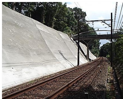
市場-小野駅間 法面補強
