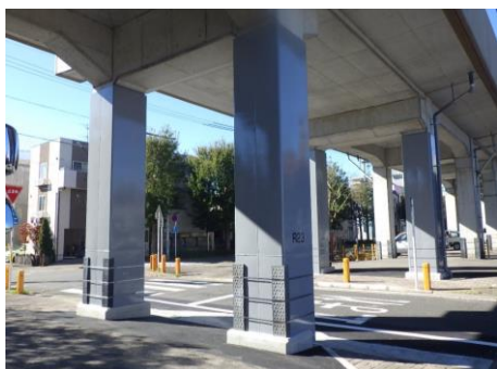
高架橋の耐震補強
