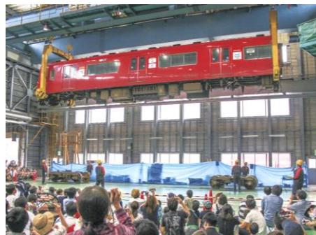
36 トンクレーン電車つりあげ作業
