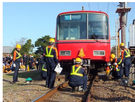
脱線復旧作業
