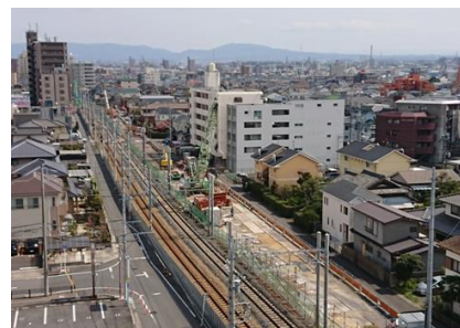
喜多山駅付近高架化工事
