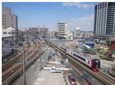
知立駅付近高架化工事
