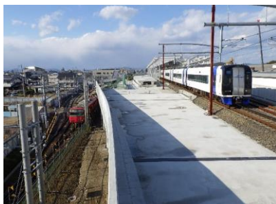
布袋駅付近高架化工事
