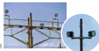
東福山駅構内に設置したLED照明
