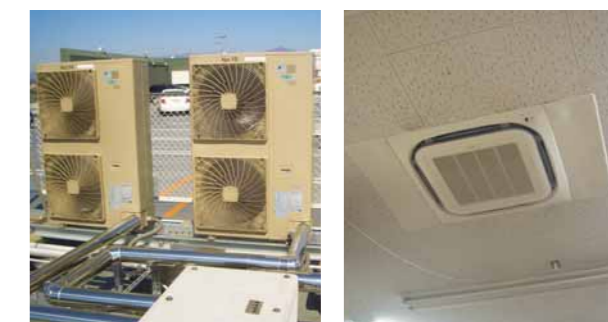
空調設備更新(ロイヤルホームセンター湘南大磯店様)
