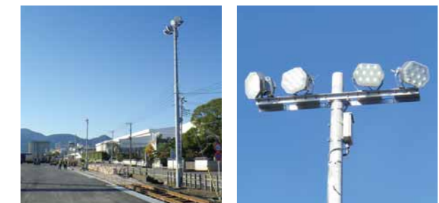
LED照明器具(富士駅)
