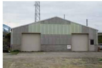
PCB保管庫(郡山総合鉄道部)
