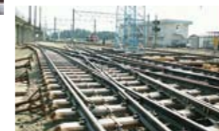
敷設の様子(盛岡貨物ターミナル駅)
