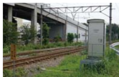
フラット検知装置全景
