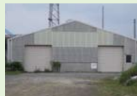
郡山総合鉄道部PCB保管庫
