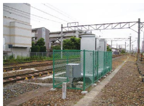
フラット自動検出装置(吹田信号場)
