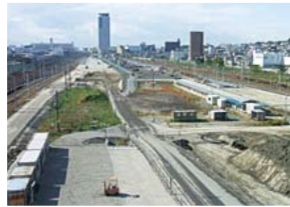
建設工事の様子
