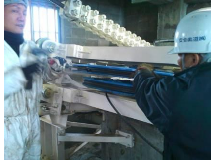
<緊張台車詰ゴム交換工事>
