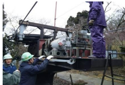
<原動モーター軸受交換工事>
