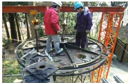
<緊張滑車 軸受交換工事>
