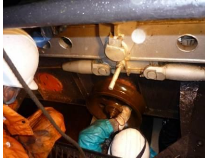
<支柱索輪交換工事>
