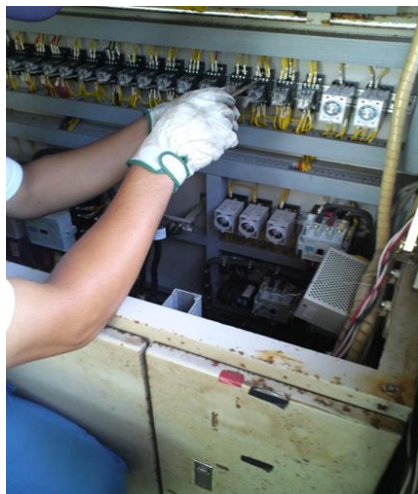
<運転制御盤部品交換>
