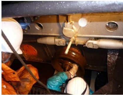
＜支柱索輪交換工事＞
