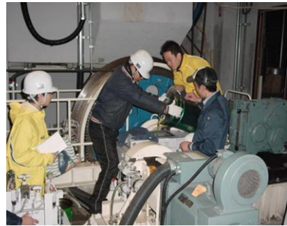
＜減速機オイル交換工事＞
