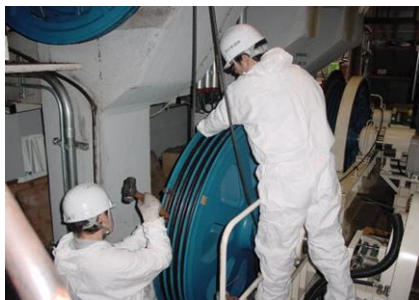
＜原動滑車詰ゴム交換工事＞
