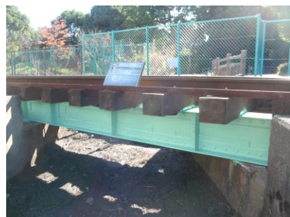
一ノ井川橋梁
