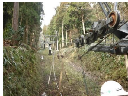
支曳索交換工事
