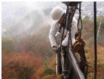
山麓・山頂ガイドローラー取替工事
