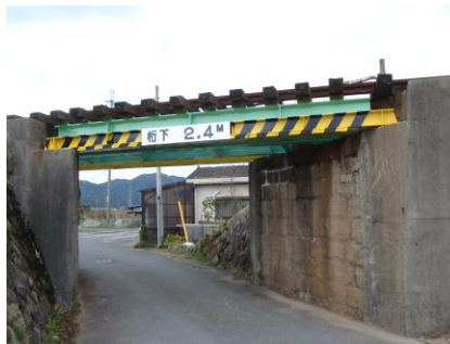
北内貴架道橋梁
