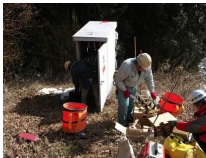
高圧電気設備改修工事
