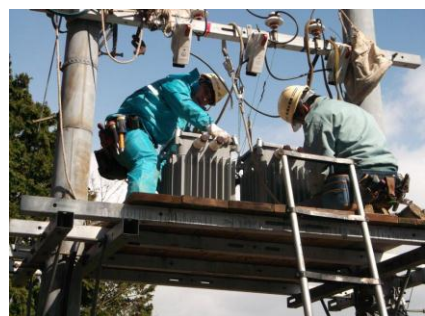
賤ヶ岳 (受電設備変圧器取替工事)
