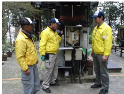
賤ヶ岳(操作盤取扱い研修)
