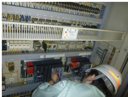
八幡山 (制御装置PLC交換工事)
