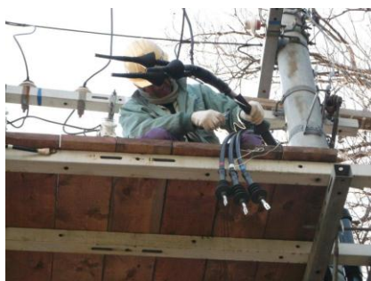
賤ヶ岳 (高圧ケーブル取替工事)
