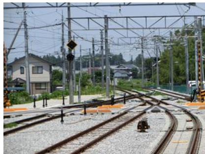
踏切道拡幅工事
