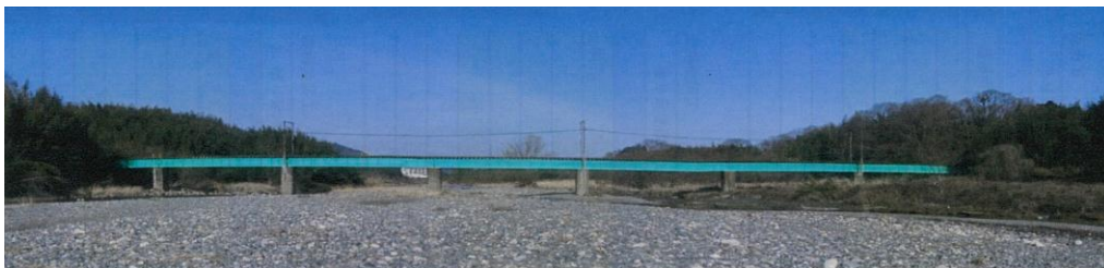
水口川橋梁改修工事
