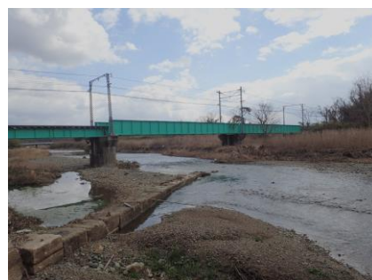
佐久良川橋梁改修工事
