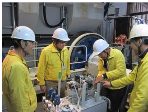
八幡山ロープウェー 索道安全ミーティング (予備原動機操作訓練)
