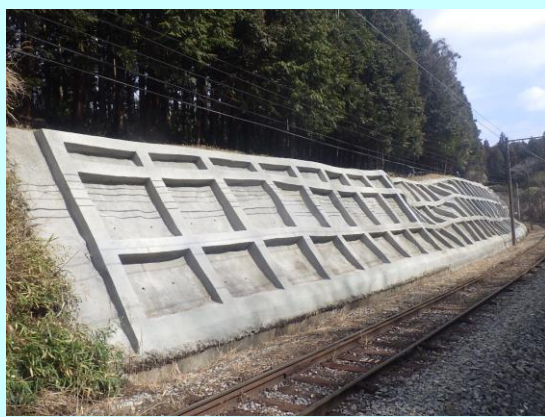
清水山トンネル付近 落石等防護設備
