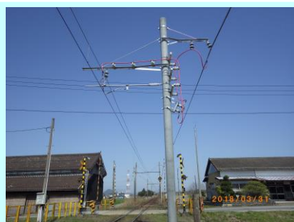
コンクリート柱化(朝日野駅)
