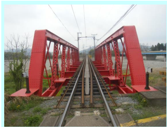
愛知川橋梁改修、落橋防止設備設置
