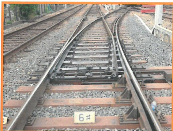
● 更新した分岐器(あびこ道構内 21S)
