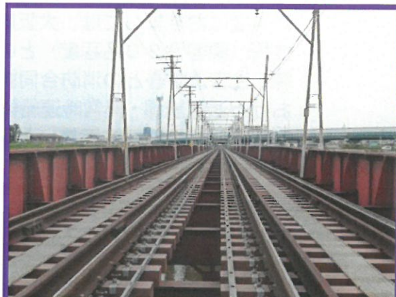
● 合成まくら木に更换した橋梁(大和川橋梁)
