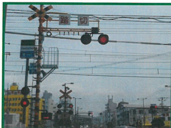
● 踏切警報機 閃光灯 LED 化(今池1号踏切)
