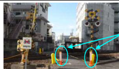
増設した規制杭
