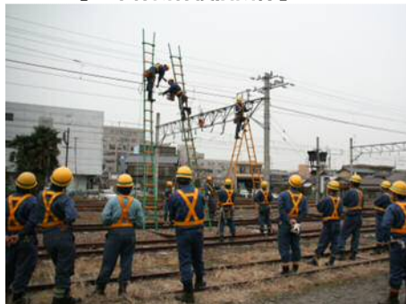
【電車線断線復旧訓練】
