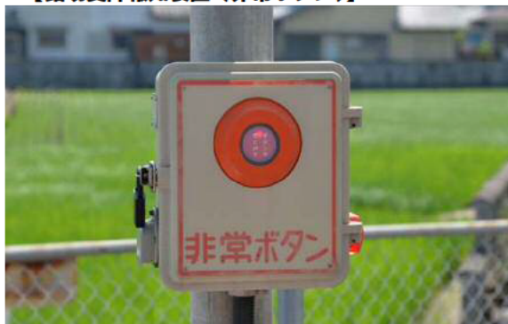
【踏切支障報知装置（非常ボタン）】
