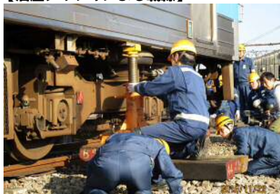
【油圧ジャッキによる載線】
