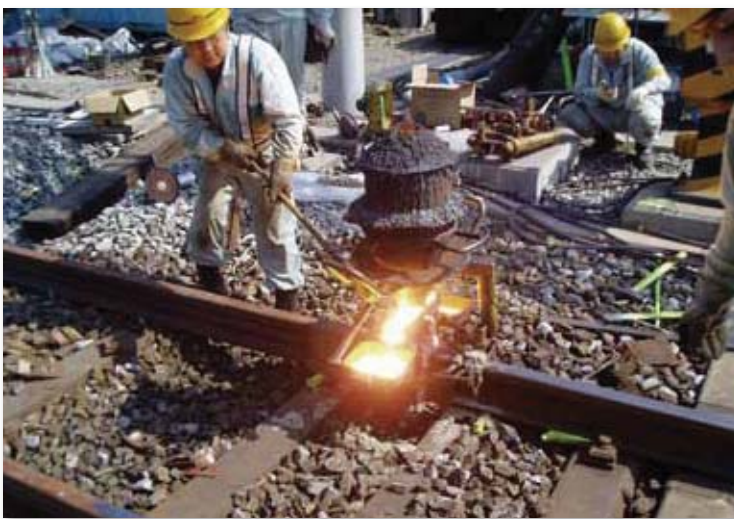
レール溶接作業
