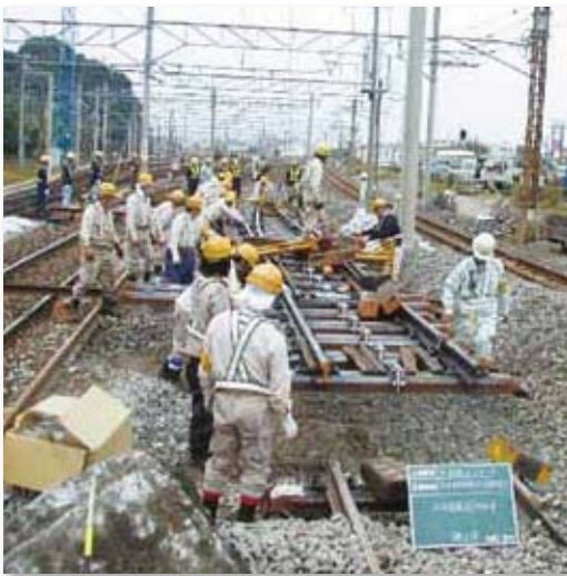
分岐器交換作業
